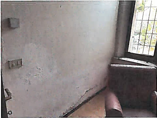
Fig. 5.5 – Immagini di degrado locale e diffuso dell'intonaco e parziale ritinteggiatura.
