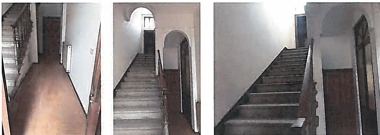
Fig. 5.2 – Immagini dell'atrio di ingresso all'edificio (a sinistra) e della scala in pietra per accedere al piano superiore.
