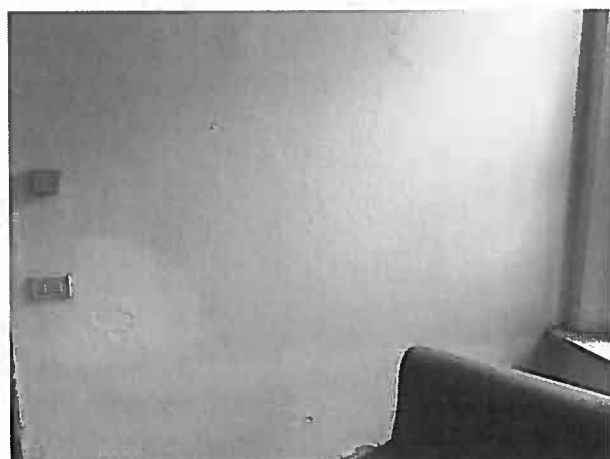
Fig. 5.1 – Nelle figure in alto a sinistra e in alto a destra si evidenzia un degrado dell'intonaco superficiale interno causato dall'umidità degli ambienti al piano terra; in basso a sinistra la figura mostra il distacco locale dell'intonaco ritinteggiato parzialmente; in basso a destra si evidenzia il degrado e conseguente distacco dell'intonaco per umidità da risalita.
